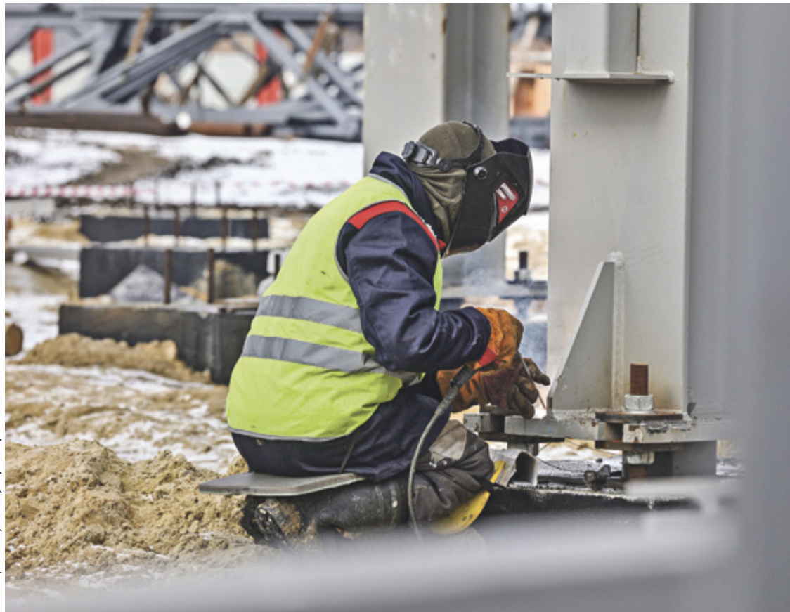
■ На маслоэкстракционном заводе, который строится в Миллеровском районе, ведутся монтажные работы
